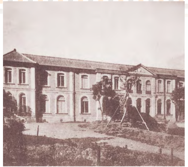
1887（明治20）年3月に完成した高等師範学校の煉瓦校舎。 ことはこの校舎で勉学に励んだ
