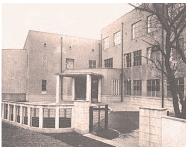
完成した鉄筋コンクリートの新校舎。
